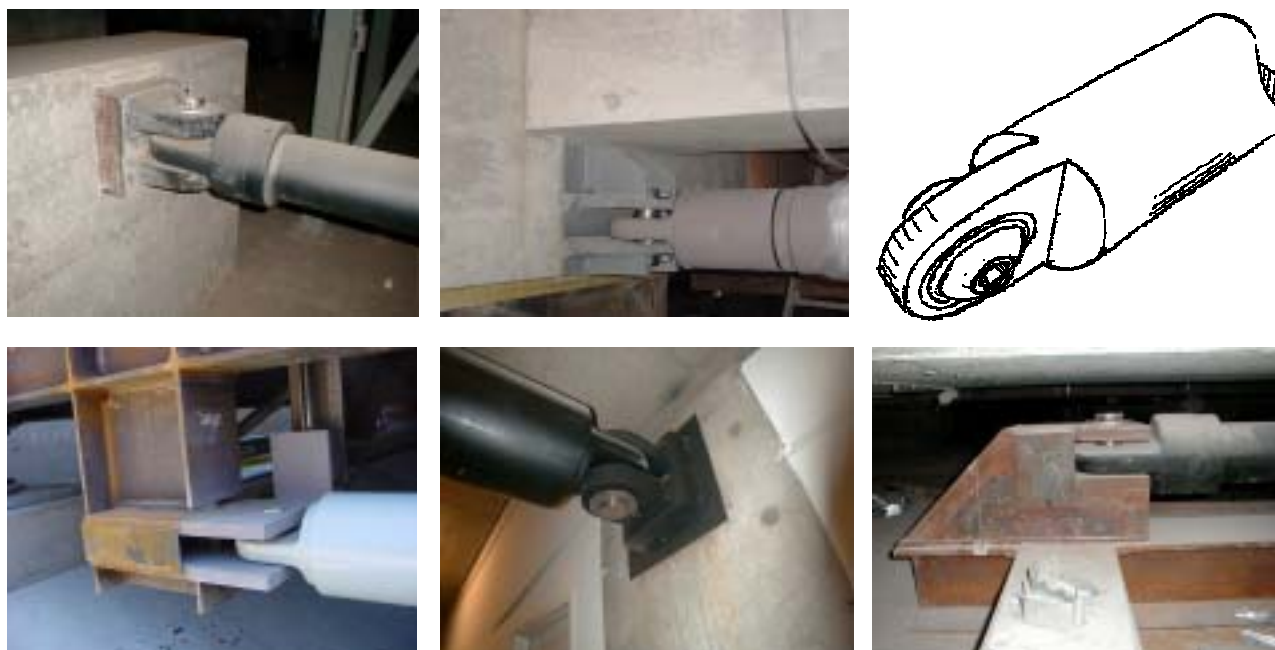
図-11 フルード粘性ダンパー球面ベアリング図と免震設置事例
