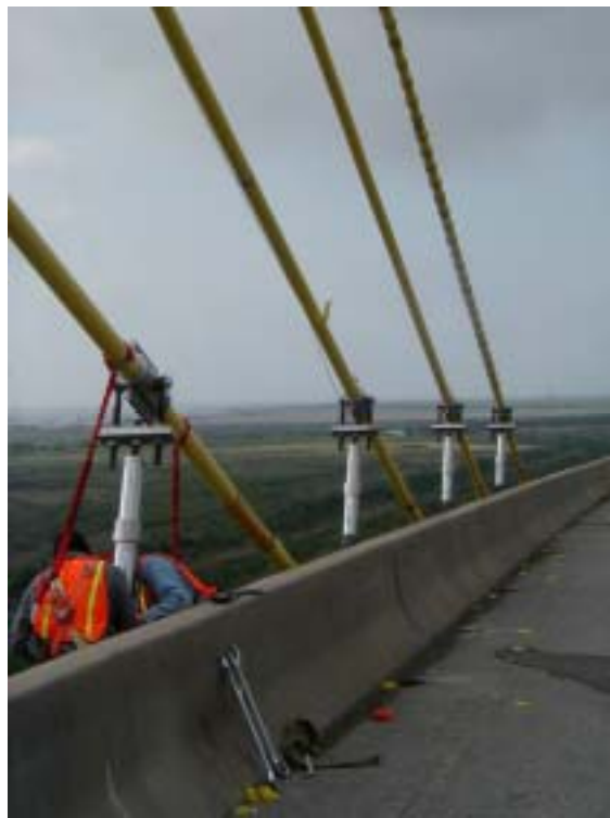
テキサス州ヒューストンのベテランズメモリアルブリッジにダンパーを設置する
